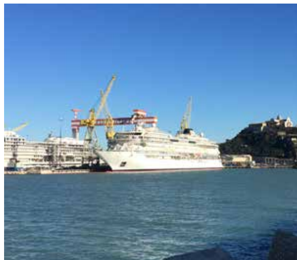
Le navi Viking in costruzione ad Ancona Viking's ships under construction in Ancona
