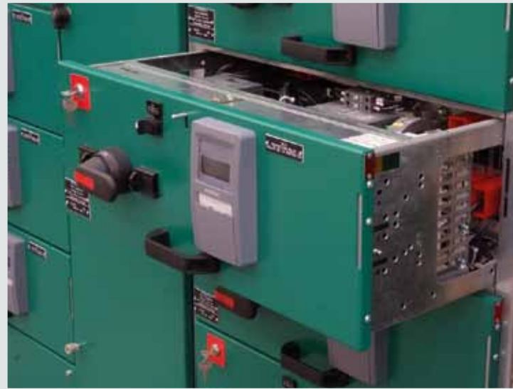
Quadri elettrici Power/Motor control center con caratteristiche elettriche 400V-1000A-50kA, dotato di cassette estraibili, per il controllo delle utenze ausiliarie dei Compressori Dresser
