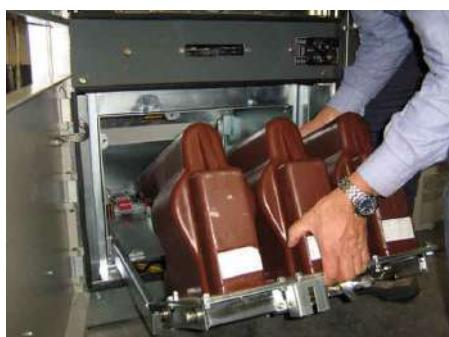
*fig.51 – Inserimento/Estrazione dei trasformatori di tensione*
