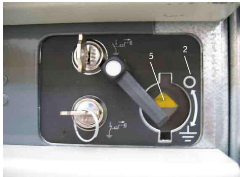
Fig. 10 - Set di manovra e di chiusura a chiave dell'sezionatore di terra (lato anteriore dell'unità)
