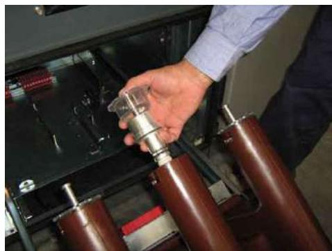
**fig-59 – Sostituzione fusibili dei trasformatori di tensione**
