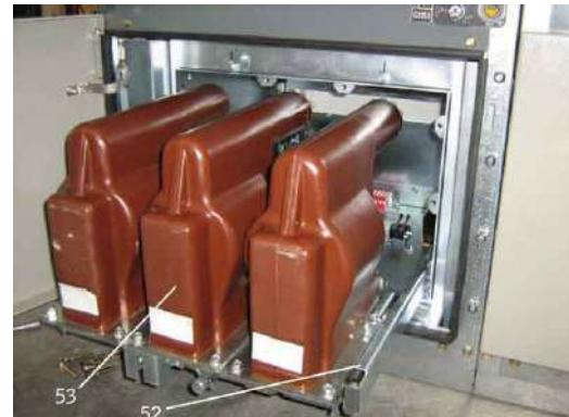
**Fig.18 - Trasformatori di tensione sul carrello estraibile**
