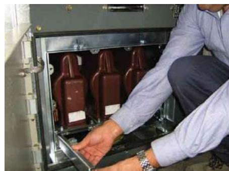
*fig.52 – Inserimento/Rimozione delle guide supplementari dei TV*
