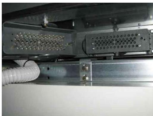
*fig.46 – Collegamento dei circuiti ausiliari*
