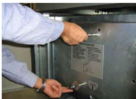
*Fig. 53 – Inserimento/Estrazione dei trasformatori di tensione*
