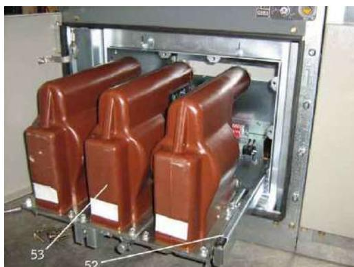
*fig.55 – Trasformatori di tensione in posizione di rimosso dalla cella TV*
