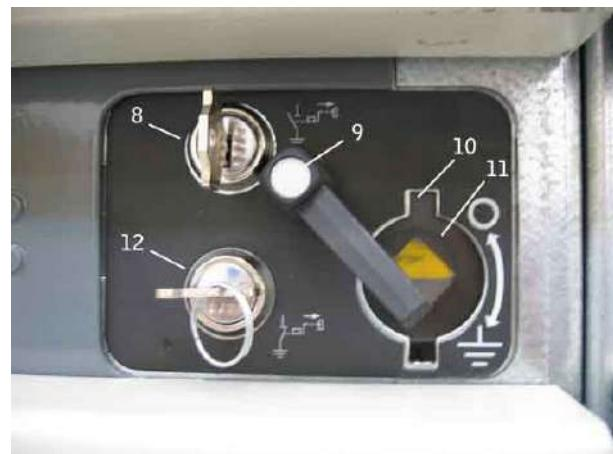
**Fig. 12 - Set di manovra e blocco a chiave del sezionatore di terra (lato anteriore dell'unità)**
