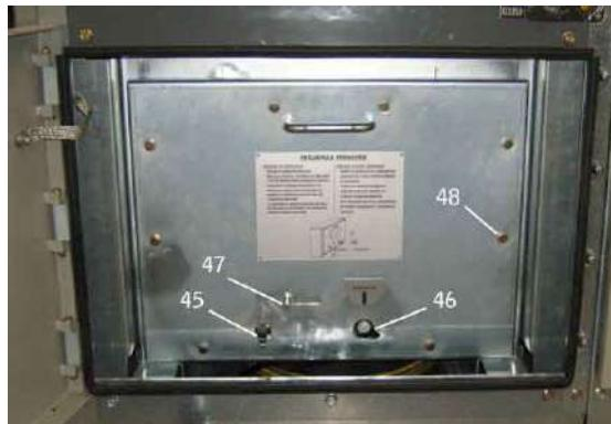
**Fig. 17 – Cubicolo dei trasformatori di tensione (porta frontale aperta)**
